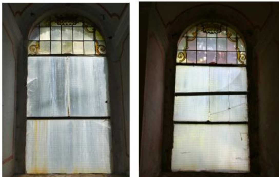
Obr. 16. Výplně oken hlavní lodi se zachovanou pouze částí vrcholové výplně.
