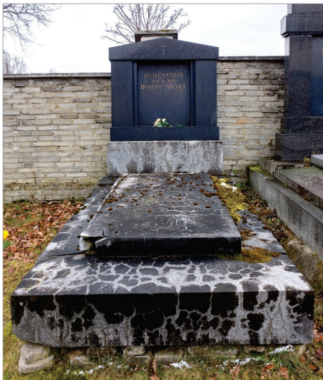
Obr. 8-10: Hrobka rodiny MÖCHEL u západní hřbitovní zdi. Z úloмку kamene z poškozeného levého předního rohu menší desky byl zhotoven broušený preparát. / Gruft von Familie MÖCHEL an der westlichen Friedhofsmauer. Von der beschädigten linken, vorderen Ecke der kleineren Grabplatte wurde von einem abgegangenen Steinsplitter ein Schliffpräparat angefertigt.
