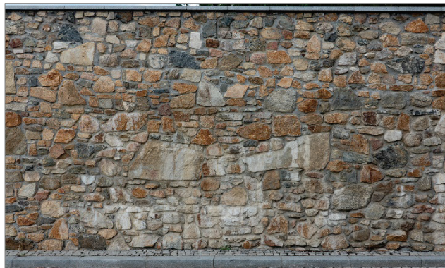
Obr. 2-14: Pestře sestavené zdivo z lomového kamene v ulici Na Příkopech v Plané. Nápadné jsou tmavé amfibolity a granátické amfibolity, které lze přiřadit mariánskolázeňskému komplexu. / Bunt zusammengesetztes Bruchsteinmauerwerk an der Straße Na Příkopech in Planá. Auffällig sind die dunklen Amphibolite und Granatamphibolite, die dem Marienbader Komplex zuzuordnen sind.
