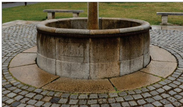
Obr. 2-15: Žula pro všechny účely: kašna, její orámování a dlažební kostky ze žuly. Petrské předměstí u autobusového nádraží v Plané. / Granit für alle Zwecke: Röhrkasten, Plattenumrandung und Pflastersteine aus Granit. Petersvorstadt beim Busbahnhof in Planá.
